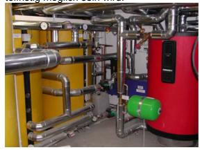
Bild-4: Solarspeicher für Warmwasser
