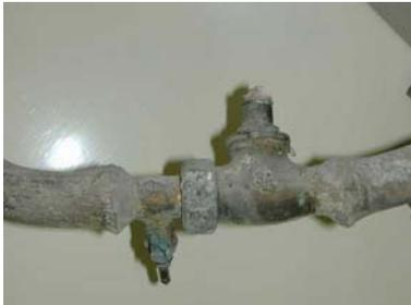
**Ein in eine Bleileitung eingesetzter Wasserhahn und Ablaufventil:**
