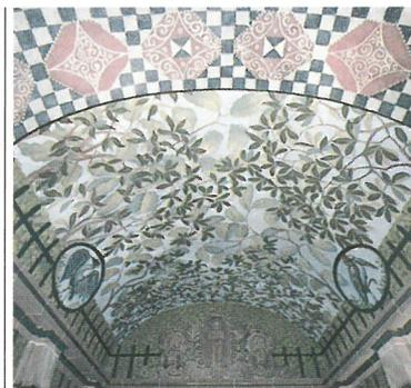
kasein beschränkten sich auf die Reinigung mit deionisiertem Wasser; kleinen Nachbesserungen mit Mineralfarben in Lasurtechnik und Festigung durch Sprühauftrag von Kieselsäureester. Das rekonstruierte Dekor der Auladecke, deren früherer Kalk-Zement-Rabitz-Aufbau allerdings aus Kostengründen einer Gipskartonplatten-Konstruktion weichen musste, entstand mittels verschiedener Schablonen und anschließenden
