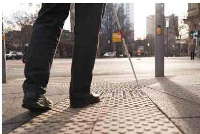
Abbildung 99: Leitsystem an einer Lichtsignalanlage für Blinde und Sehbehinderte.
