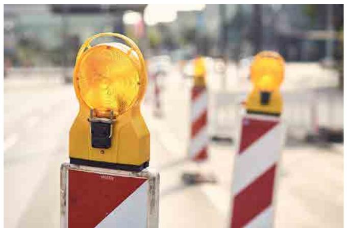
Abbildung 122: Baken zur Führung des Verkehrs an einer Straßenbaustelle.
