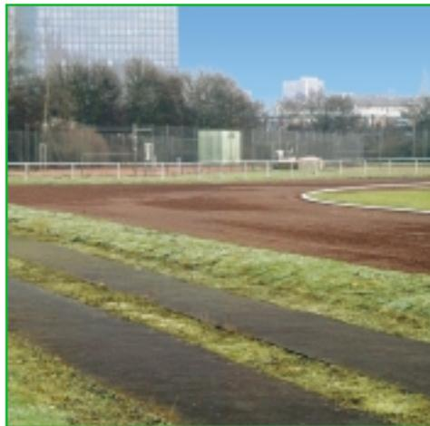
Im Zuge der Baumaßnahme wurde festgestellt, dass Teile des Bodens schadstoffbelastet waren. Die Erde musste daher teilweise ausgebaut und durch unbelastetes Material ersetzt werden. Durch diese unvorhergesehene Verzögerung konnte der Kunststoffbelag nicht wie ursprünglich geplant noch im Herbst 2002 aufgebracht werden. Dies ist nun je nach Witterungslage für Ende April/Anfang Mai 2003 vorgesehen. Mit der Fertigstellung ist dann Ende Mai 2003 zu rechnen.
