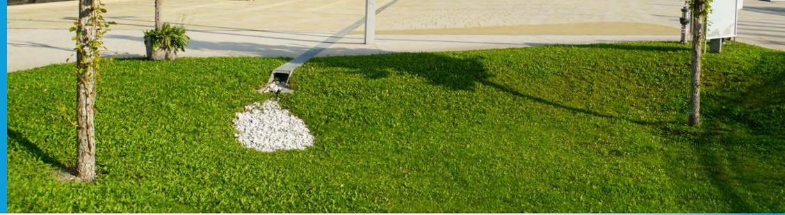
Die dezentrale naturnahe Regenwasserbewirtschaftung vor Ort führt zur Verdunstung und Versickerung des Niederschlagswassers und spart bei der Nutzung als Brauchwasser Trinkwasser ein. Dies stärkt den natürlichen Wasserkreislauf und hat einen positiven Effekt auf das Stadtklima. Der reduzierte Abfluss entlastet die öffentlichen Entwässerungsanlagen und Gewässer, was darüber hinaus dem Hochwasserschutz und der Starkregenvorsorge dient.
