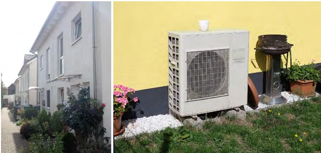
Abb. 124: Reihenhäuser mit Wärmepumpen-Heizsystem. Rechts eine Außeneinheit einer Luft/Wasser-Wärmepumpe (Fotos: ebök)
