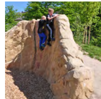
Abb. 13: Geländestützmauer als Kletterwand
