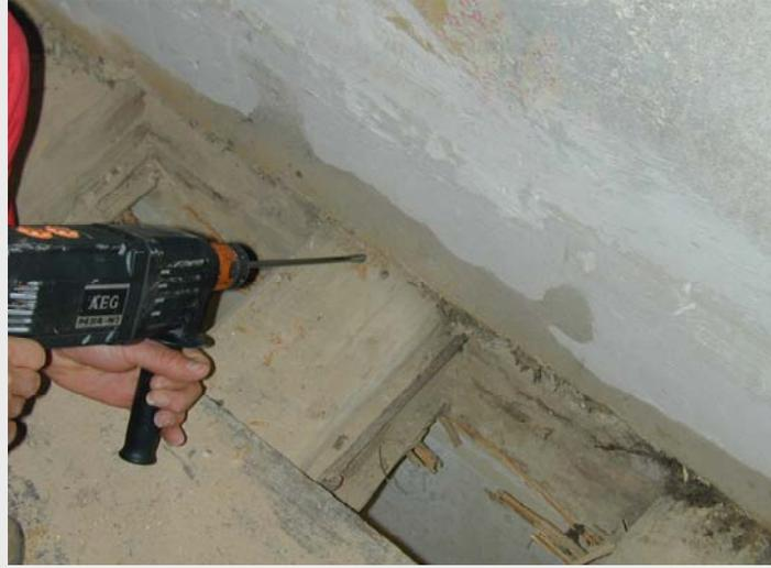
**Bild 27: Anordnung der Feuchtemessstellen im Balkenkopf**
