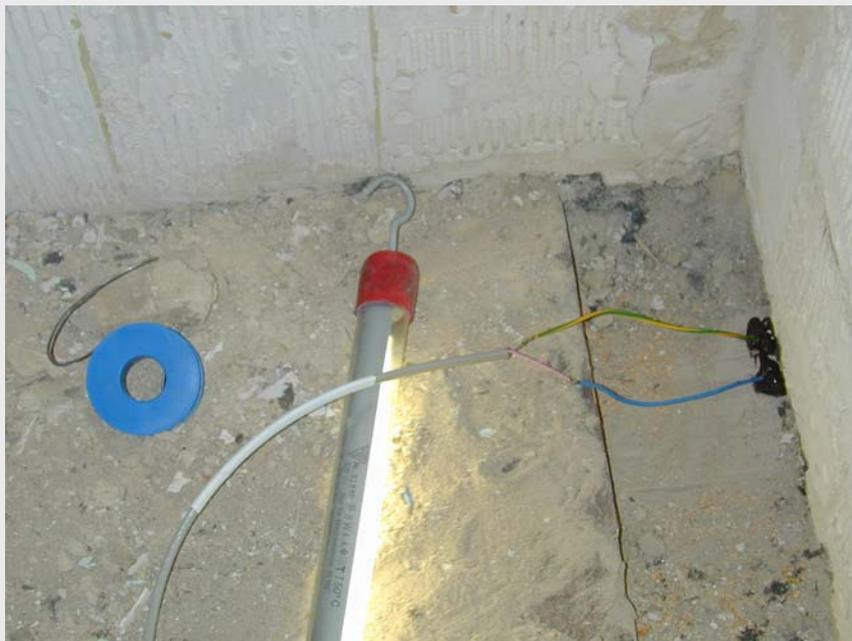
**Bild 34: linkes Bild: in einem Lehrrohr auf dem alten Fußboden verlegtes Messkabel**
