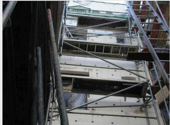
**Bild 14: Detailansicht im Fensterbereich vor Anbringung der Laibungsdämmung**
