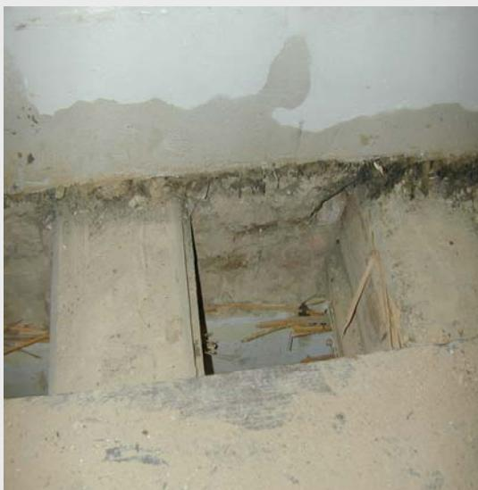
**Bild 25: Ansicht eines Balkenkopfes**
