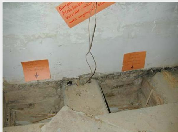
Zur Verbindung der Messstellen mit den Messdosen im Treppenhaus wurden mehradrige, abgeschirmte Kabel verwendet, die in Leerrohren in der Ausgleichsschüttung des neuen Fußbodens verlegt wurden. Die Abschirmung wurde geerdet.
