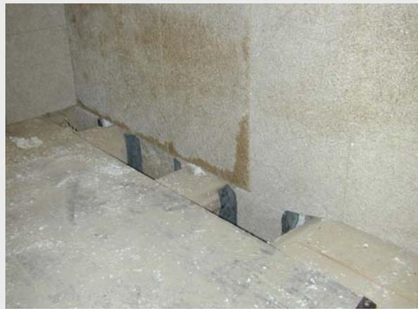
**Bild 36: linkes Bild: Zum Ausstopfen der waagerechten Fuge wurde die unterste Dämmplatte im Raum vorübergehend wieder entfernt.
