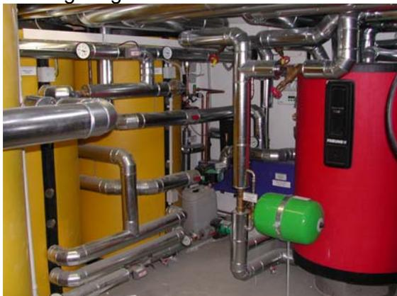
**Bild-4: Solarspeicher für Warmwasser**
