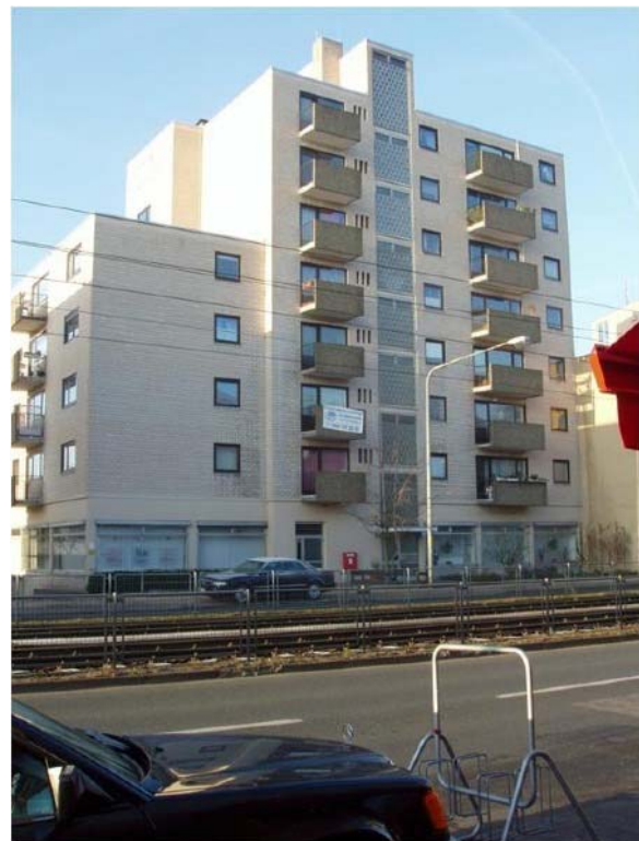
(Bild: Wohngebäude Eschersheimer Landstraße , Quelle Aquaform)
