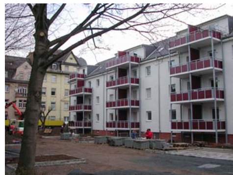
Bild 2 – erstes saniertes Gebäude – Breitlacher Str. 91 mit thermisch getrennten Balkonen.
