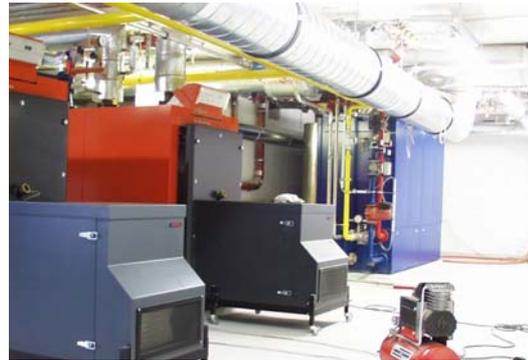
**Bild 3: Heizzentrale Niedwiesenstraße 103 mit Kessel- und KWK-Anlage**
