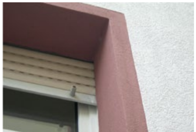
Abbildung 9: Nachbildung der Fenstergewände als Putzfasche (Foto: Jürgen Werner)
