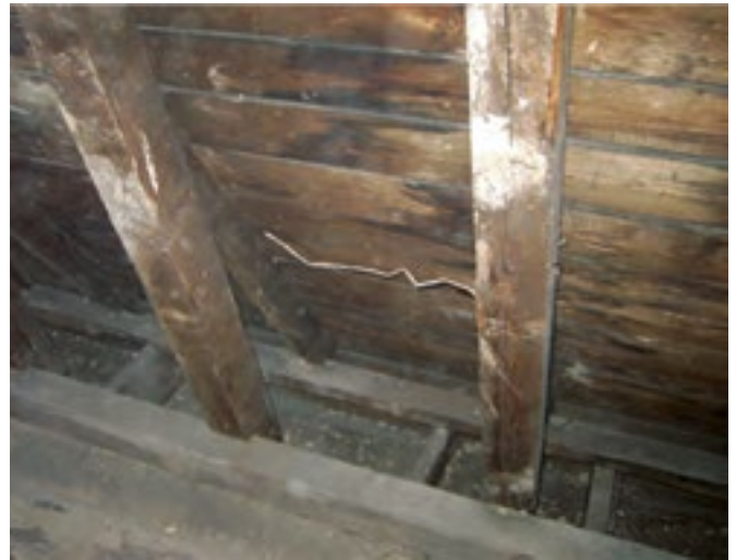
Abbildung 14: Freigelegte Sparrenkonstruktion mit Holzschalung (Quelle: Klimareferat)
