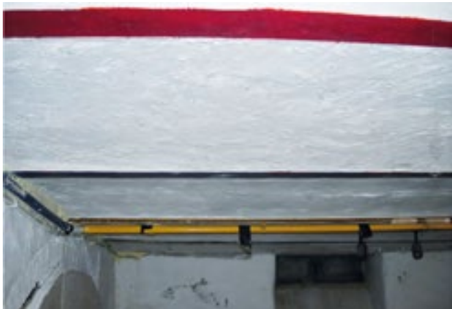
Abbildung 13: Kellerdecke als verputzte Kappendecke (Foto: Jürgen Werner)
