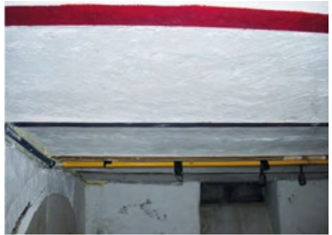
Abbildung 3: Kellerdecke (Foto: Jürgen Werner)
