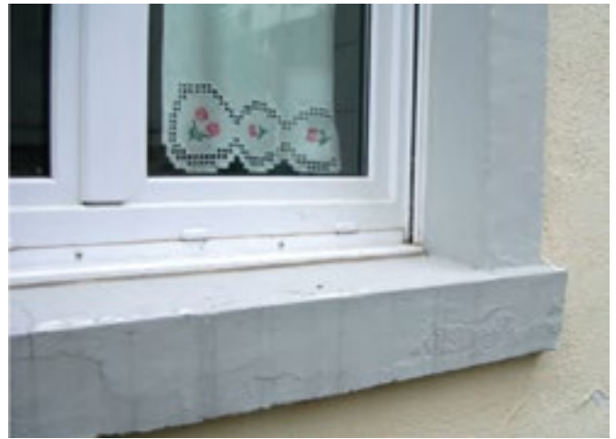
Abbildung 8: Fensterbank im Bestand (Foto: Jürgen Werner)
