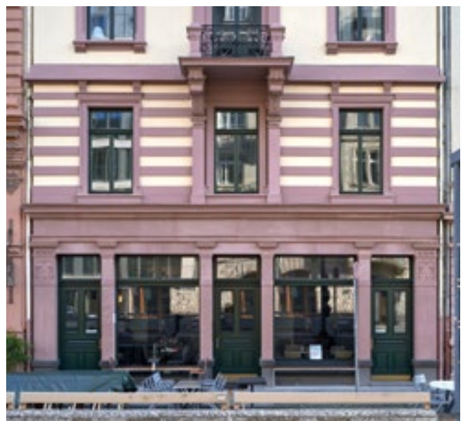
Abbildung 2: Fenster mit Sprossenteilung und Oberlicht (Quelle: Denkmalamt, Foto: Marcel Schawe)
