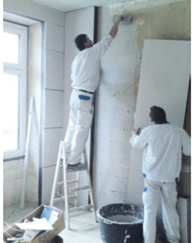
Abbildung 11: Einbau einer Innendämmung an einer Straßenfassade in der Mörfelder Landstraße 46 (Quelle: arch+E Architekten)
