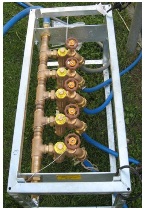
**Abb. 57** Trinkwasserunterverteilung mit Einzelanschlüssen
