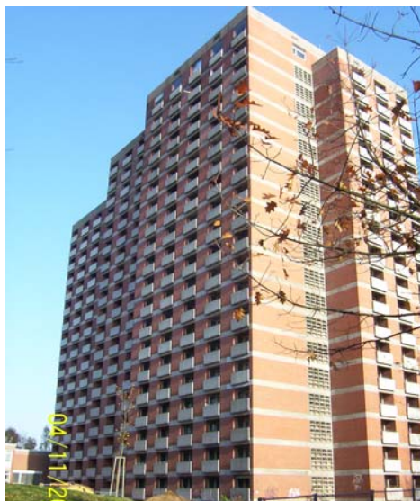
Bild-2: Gebäude vor der Sanierung
