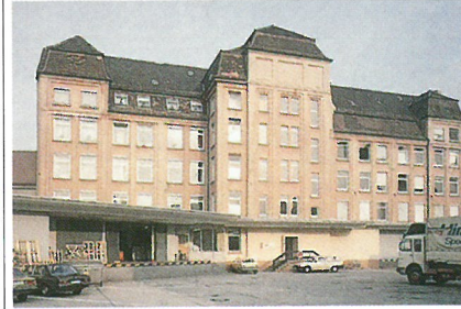
zahlreiche Firmen sich auf die Herstellung von Schlaf-, Wohn- und Herrenzimmern spezialisiert hatten. Am besten erhalten die Fabrikgebäude von C. Jughardt (1904, Bahnstraße 2, Praunheimer Werkstätten) und Heist & Hobraeck (1906, König- steiner Straße 86) mit neobarocker Hauptfassade.
