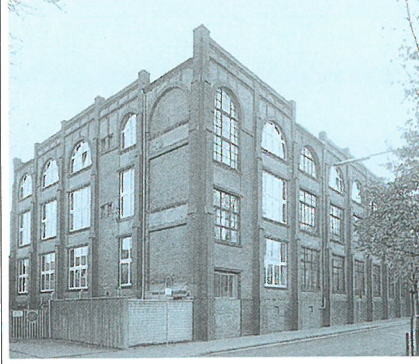
Ehem. Maschinen- und Armaturenfabrik vom. H. Breuer & Co., Kurmainzer Straße 2, Palle- skstraße. Die 1874 von Hermann Breuer aus Elber- feld in Sachsenhausen gegründete Firma ent- wickelte sich nach dem Umzug 1878 mit der Pro- duktion von Gas- und Wasserarmaturen zu dem nach der „Rotfabrik“ größten Industrieunternehmen in Höchst. Von dem ausgedehnten Fabrikkomplex blieb allein ein der norddeutschen Backsteingotik verpflichtetes Fabrikgebäude von 1907 erhalten.
