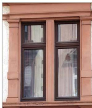
Bild 3: Fensterteilung durch Wandkonstruktion
