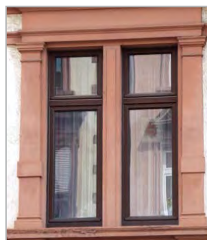
Fensterteilung durch Wandkonstruktion
