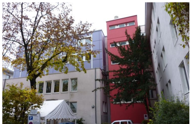
Abb.11: Treppenhaus von Innenhof
