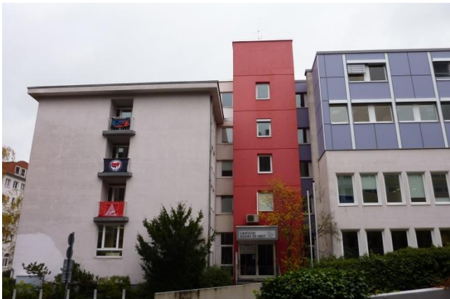
Abb.8: Eingang/Treppenhaus (von Mertonstr.)
