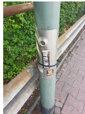
(Mastklappe wegen Kabelbinder nicht erreichbar)
