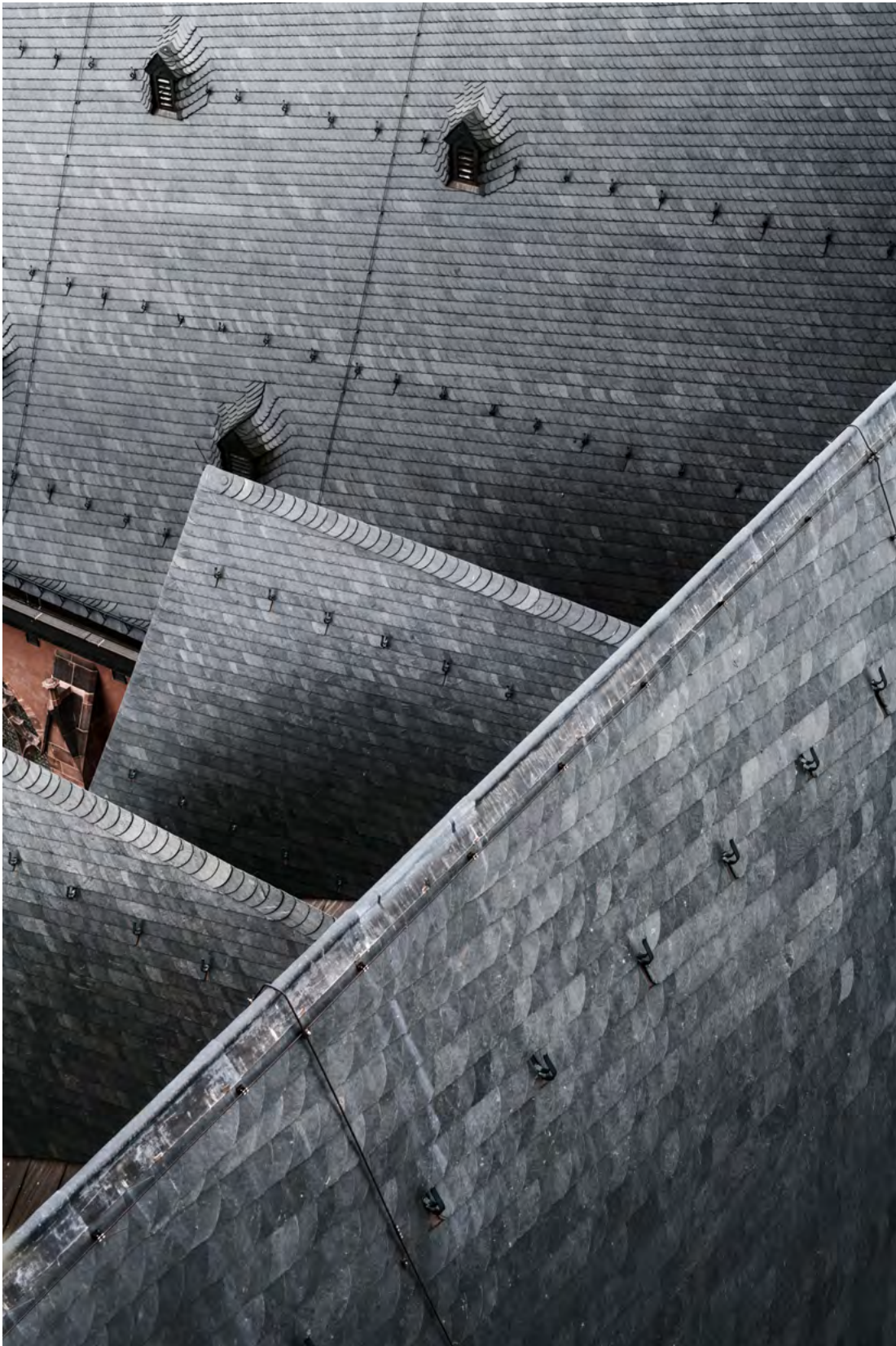
Nach Vorgaben des Denkmalschutzes: Fachgerechte Sanierung der Dächer des Domes
