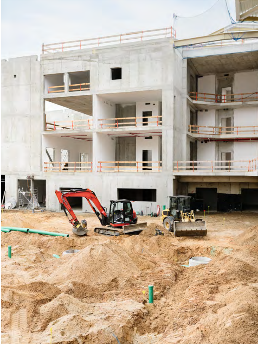
Bauarbeiten an der neuen Sport-Akademie des DFB
