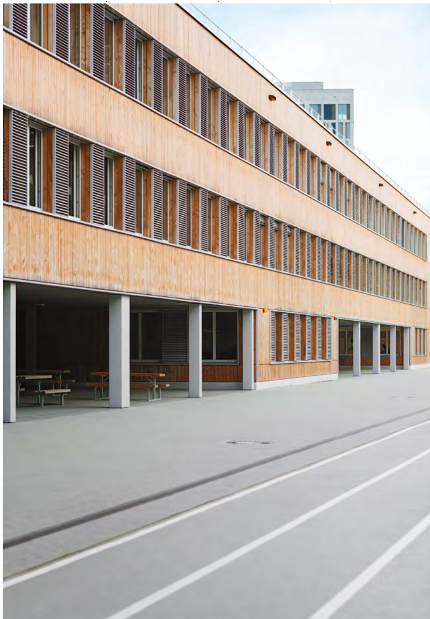
Schulcampus Westend in Holz- modulbauweise: Ein exemplari- sches und zukunfts- weisendes Projekt
