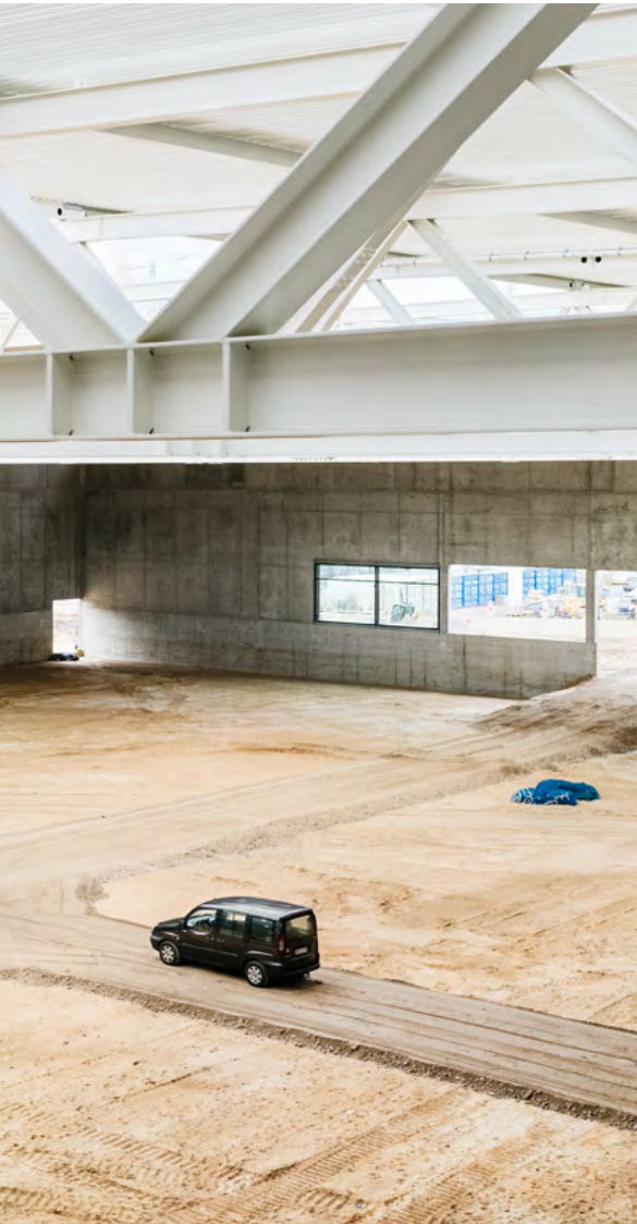
Viel Platz für den Fußball: Blick in den Rohbau der neuen DFB-Sport-Akademie
