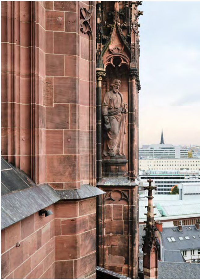
Im Zentrum der Altstadt: Ein historisches Wahrzeichen von Frankfurt
