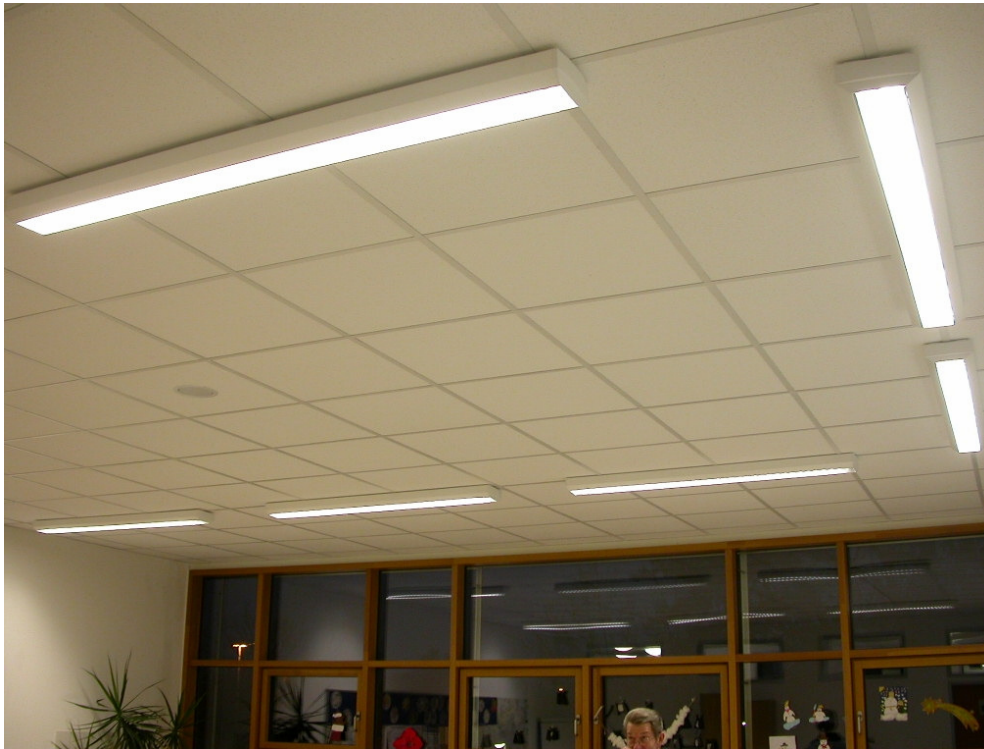
Fig. 6: Schule am Ried, classroom 116
