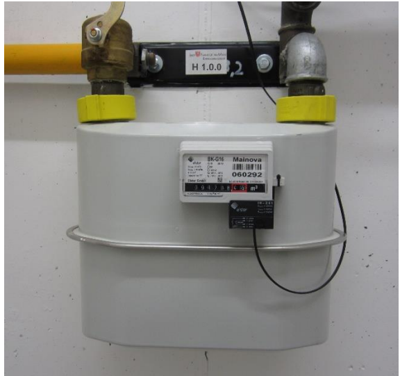
Gaszähler mit Impulsausgang
