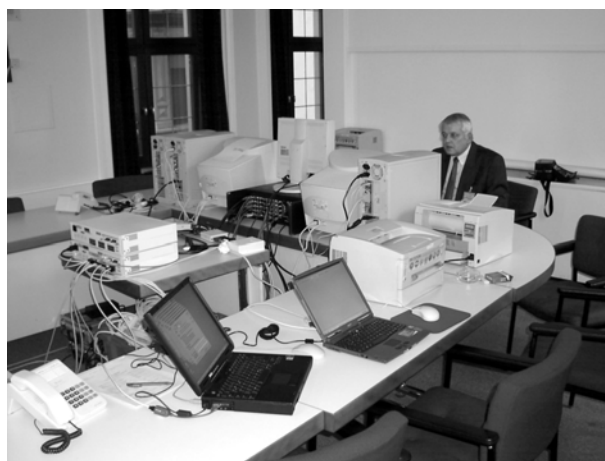
... und die Steuerungsanlage im Regiezentrum
