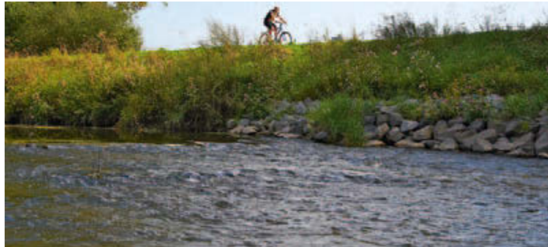
Raue Rampe am Bonameser Altdurchstich 2001 strömt hier die Nidda noch langsam dahin, die Wasseroberfläche ist glatt (links). 2011 sorgt die neu gebaute Raue Rampe dafür, dass Niddawasser auch in den nun wieder beidseitig angeschlossenen Altarm hineinströmt, dabei wird das Wasser turbulent (rechts).
