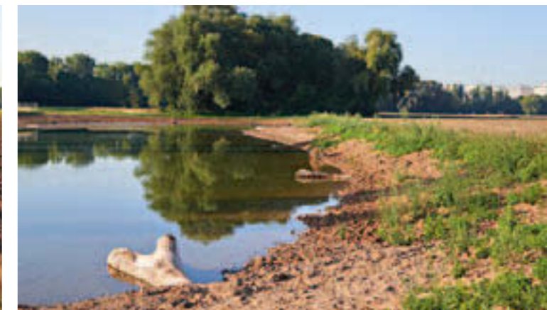
Bis 2019 lagen hier noch Felder (links), dann wurde der Main-Nebenarm ausgehoben und nach dem Durchstich füllte er sich mit Wasser.
