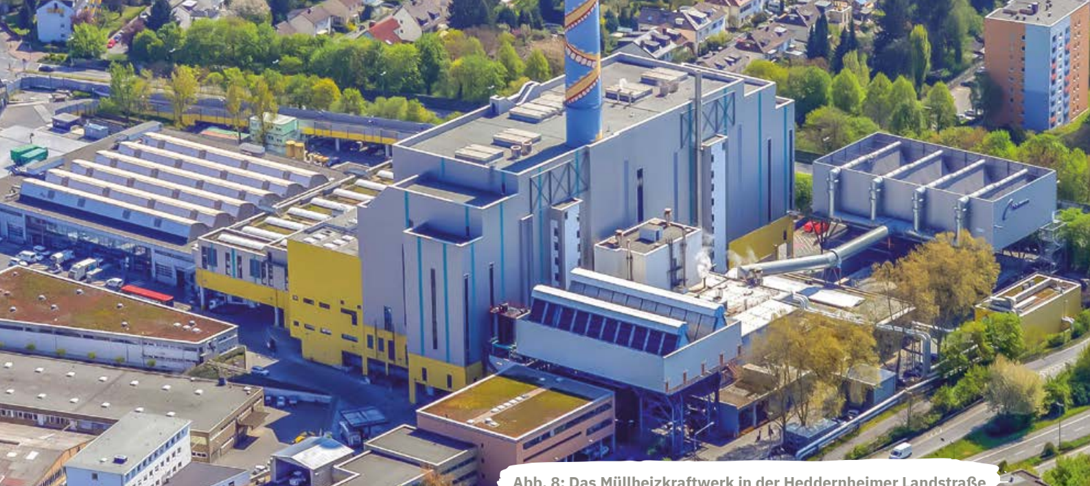
Abb. 8: Das Müllheizkraftwerk in der Hedderheimer Landstraße
