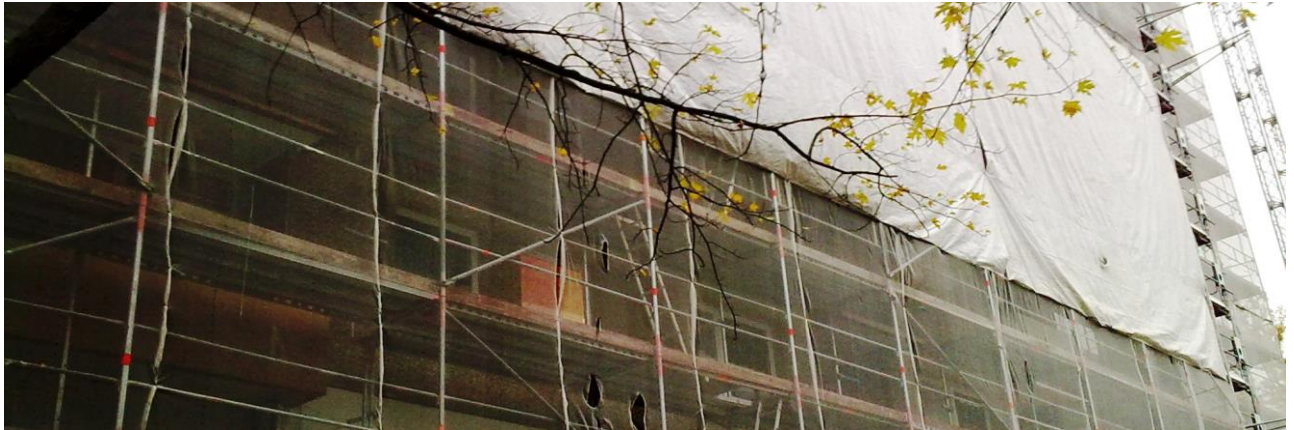
Fassadenreinigung © Stadt Frankfurt am Main, Foto: Sandro Alessi, Umweltamt
