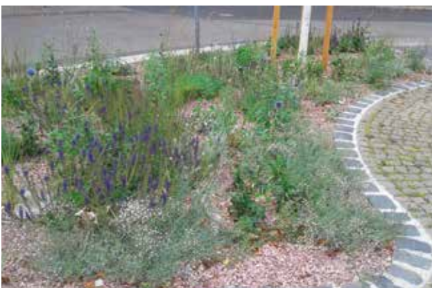
Niveaugleiche Einfassung am Luisenplatz, Niederschläge fließen in das Pflanzbeet ab © Grünflächenamt
