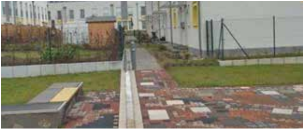
Lindenviertel, Muldenrinne im Pflaster © Grünflächenamt
