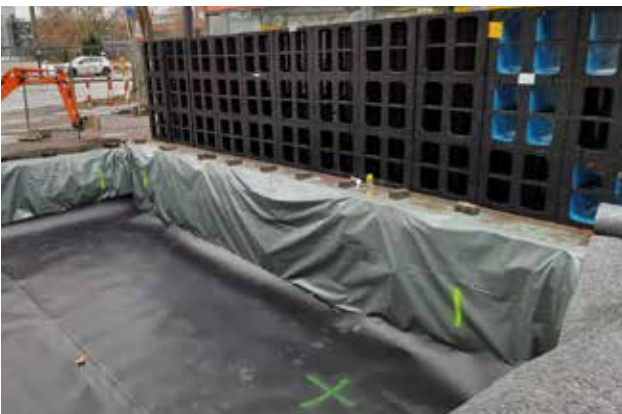
Hohlkammerrigolen werden für den Einbau vorbereitet © Stadtentwässerung
