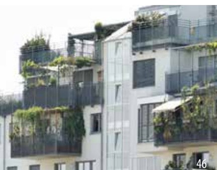
Helle Fassaden- und Dachflächen sowie Gebäudebegrünung
