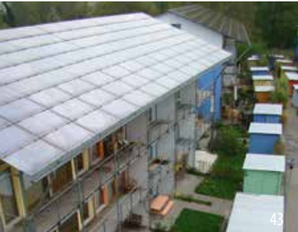
Solarsiedlung Freiburg mit integrierten Photovoltaikanlagen auf den Dächern
