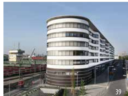
Zertifiziertes Gebäude des Grünflächenamtes
