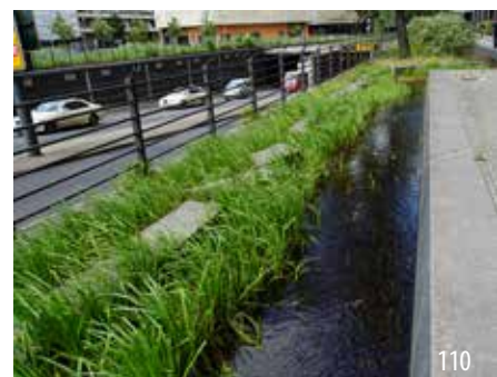
Regenwasseranlage über einer Verkehrsachse
