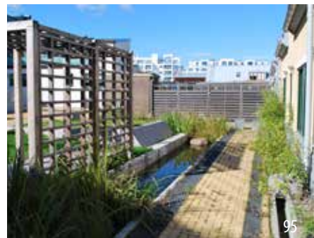
Regenwasser als sichtbares, oberirdisches Element der Quartiersgestaltung
