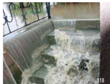
Sturzflut ergießt sich in einen Keller
