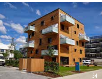
Fünfgeschossiges Wohnhaus in fast vollständiger Holzbauweise
