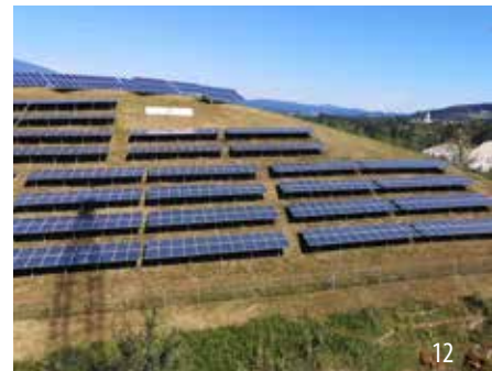
Doppelnutzung von Flächen: Deponie dient der Energiegewinnung
