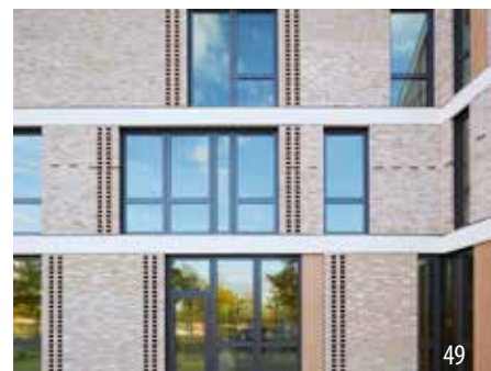
Passivhausbau im Schulbereich
