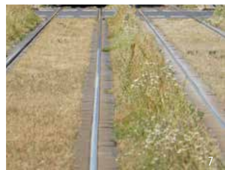
Grüne Gleisanlagen im sommerlichen Trockenstress
