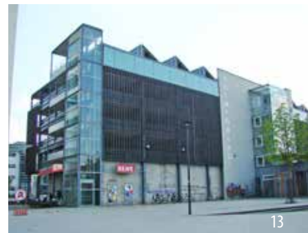
Supermarkt, Parkhaus und Energiegewinnung auf einem Grundstück
