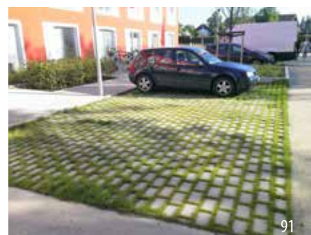
Begrünte, versickerungsfähige Befestigungsmaterialien im Stellplatzbereich
