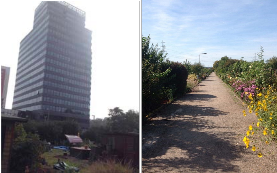
Abbildung 36 Hochbauten und freie Blickbeziehungen in der unmittelbaren Nähe der Anlagen (links 150 – Niederrad, rechts 93 – Gneisenau)
