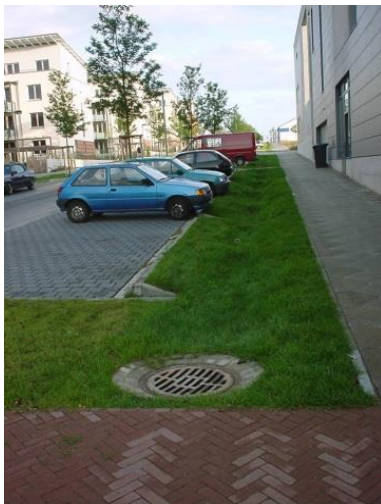
Abb. 12: Mulden-Rigolen-System im Baugebiet Hannover-Kronsberg
