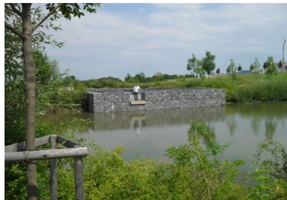
Abb. 13: Regenwasserbewirtschaftungsanlage im Baugebiet Riedberg (Quelle: Stadtentwässerung FFM)
