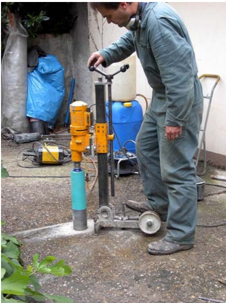
Bohrung für eine umwelttechnische Untersuchung
