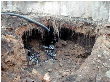
Sanierung eines ehemaligen Gaswerks, kontaminierter Boden
