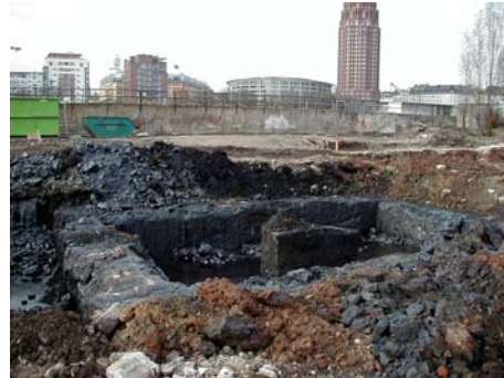
Sanierung eines ehemaligen Gaswerks, Teergrube
