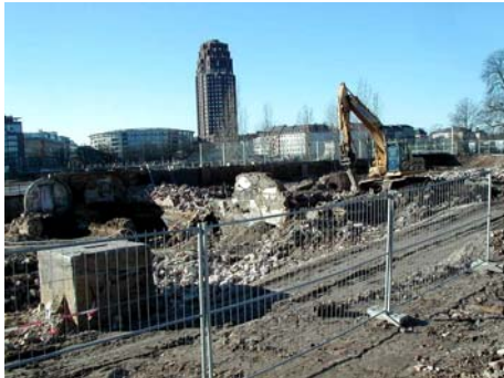
Sanierung eines ehemaligen Gaswerks
