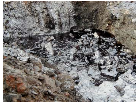
Sanierung eines ehemaligen Gaswerks, Teeröl
