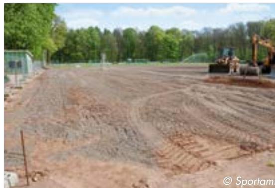
Die Sportanlage Beckerwiese als Großbaustelle...
