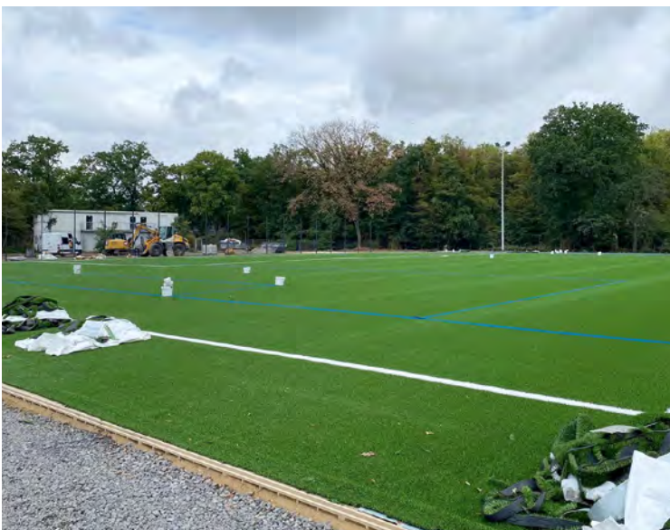
Auf der Sportanlage Birsteiner Straße: Bau eines Kunstrasen-Großfeldes...
