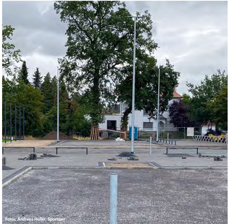
Vorbereitungen für den Bau einer Fitnessanlage
