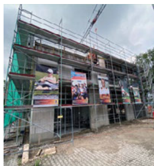
Noch vor kurzer Zeit: die Boots- haus-Baustelle
