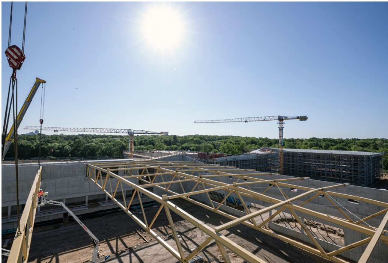
Dachkonstruktion des neuen DFB und seiner Akademie
