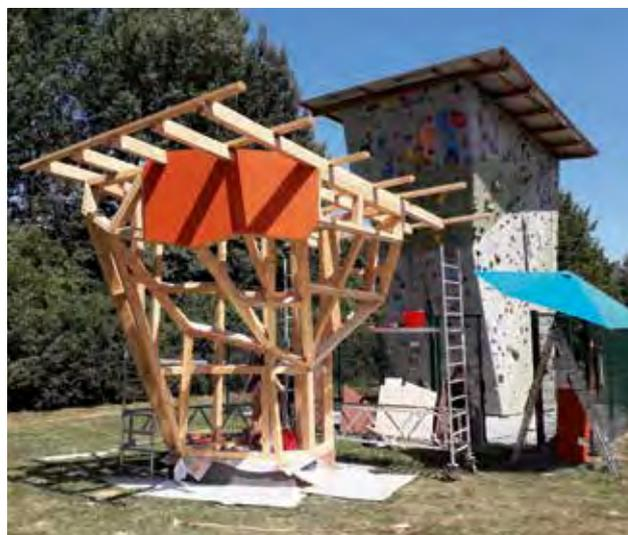
*Der Boulderblock aus 128 Holzteilen wurde auf das Fundament gesetzt und die Platten mit 2.400 Schrauben auf dem Holzgerüst befestigt.*
