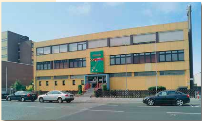
Die städtische Sporthalle „Fabrik Sporthalle“ in der Wächtersbacher Straße
