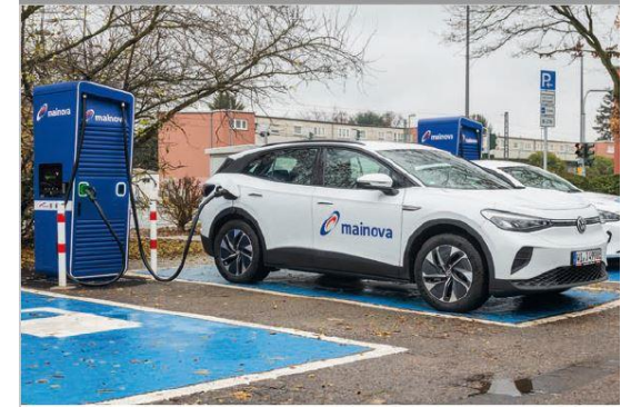
Ladestation © Mainova AG
