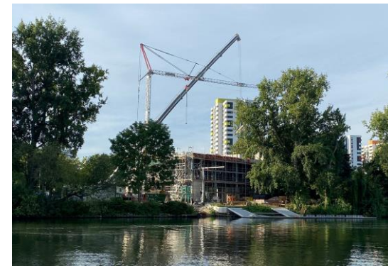
Bau eines neuen Jugend- und Schulruderzentrums am Main
