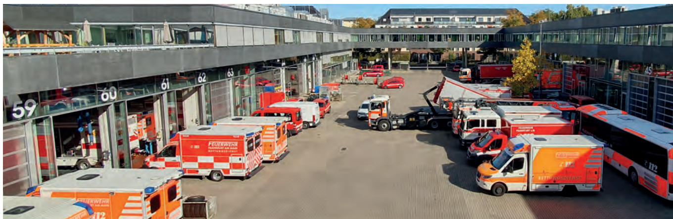
Brandschutz-, Katastrophenschutz- und Rettungsdienstzentrum Frankfurt am Main – Sitz der BKRZ GmbH & Co. KG
