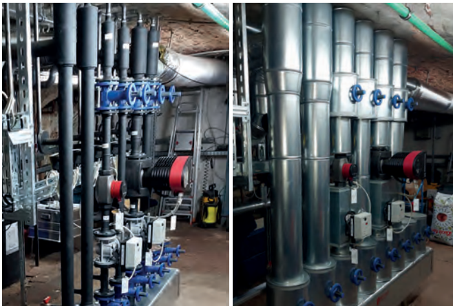
Heizungsunterstation 3 – vor und nach der Isolierung
