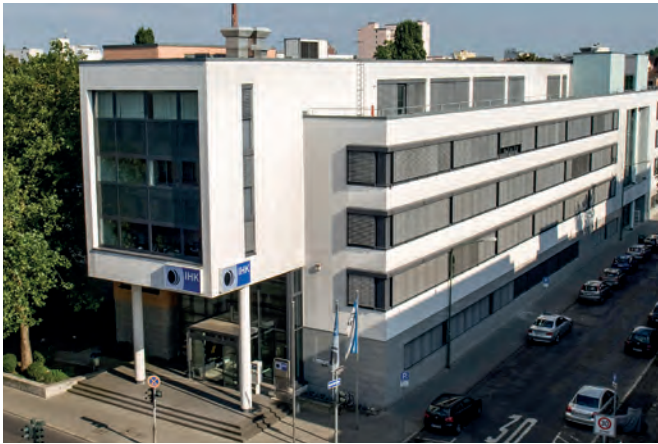
Gebäude der IHK Offenbach
