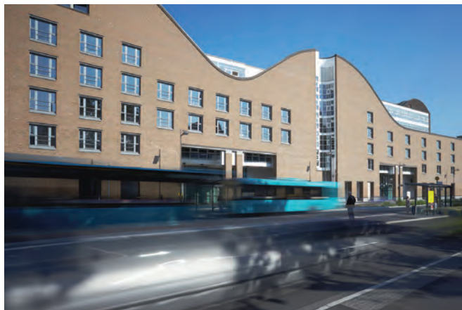
Ansicht Gebäude Kurt-Schumacher-Straße 10
