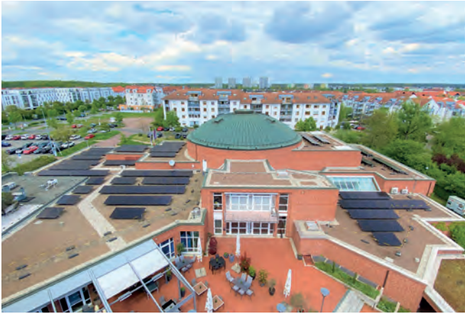
Photovoltaik-Anlage und Gründach auf 1.850 m 2 Dachfläche
