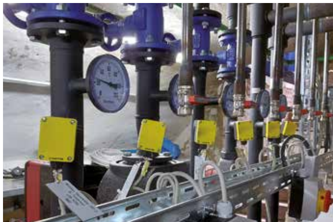
Gebäudeleittechnik – Heizungssteuerung
