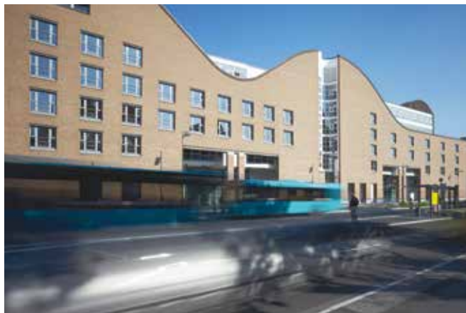
Ansicht Gebäude Kurt-Schumacher-Straße 10
