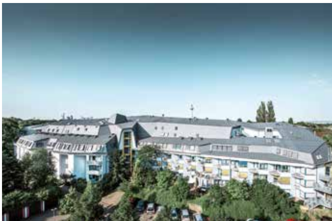
Energetisch saniertes Dach (2016/2017)
