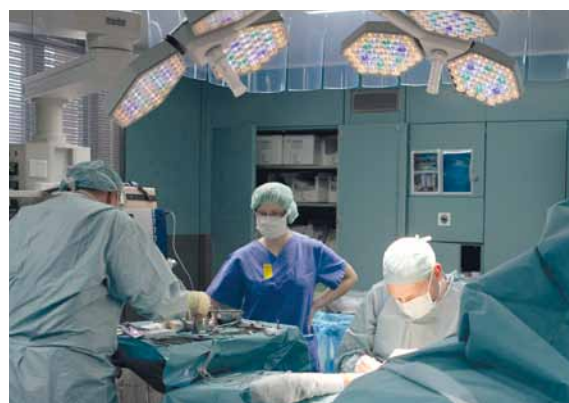
OP-Saal im Krankenhaus Bad Soden
