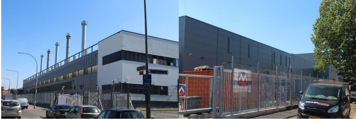
Abbildung 26: Rechenzentrum der Fa. Equinix in der Kruppstraße
