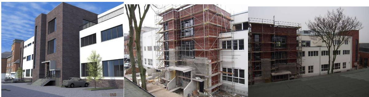
Abbildung 43: Ansichten vom Neubau im Cassellapark
