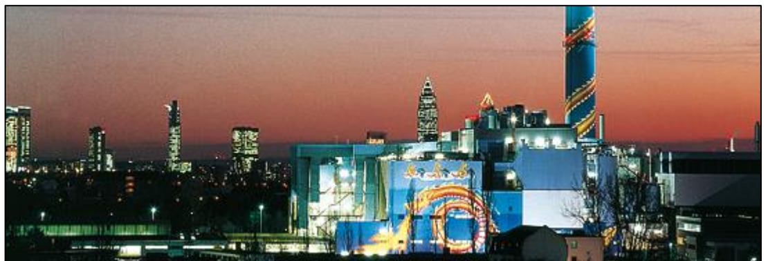
Abbildung 58: Müllheizkraftwerk Nordweststadt, Quelle: Müllheizkraftwerk Frankfurt.
