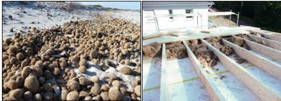
Abbildung 118: Dämmmaterial aus Meeresgras, Quelle (NeptunTherm 2014).
