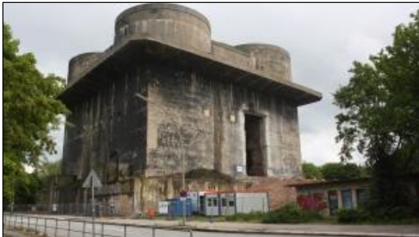
Abbildung 99: Wärmespeicher im Bunker in Hamburg-Wilhelmsburg, Quelle: FAZ.
