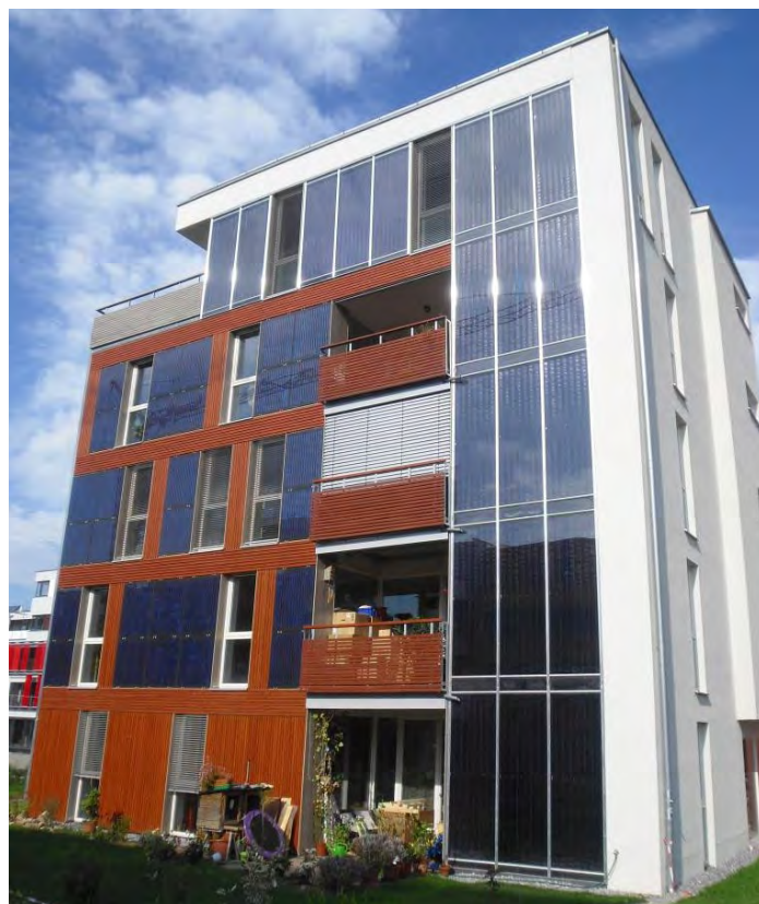
Abb. 18: Beispiel für die Integration von Sonnenkollektoren (oben und rechts) und Photovoltaik-Modulen (links) in die Fassade eines Mehrfamilienhauses in Tübingen. (Quelle: Tourismus Marketing GmbH Baden-Württemberg)
