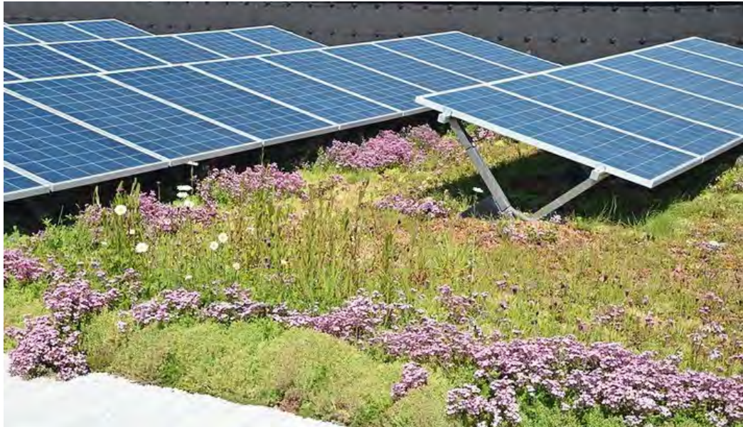
Abb. 20: Beispiel für die Kombination von Photovoltaik-Modulen mit einer extensiven Dachbegrünung. (Quelle: Paul Bauder GmbH & Co. KG)
