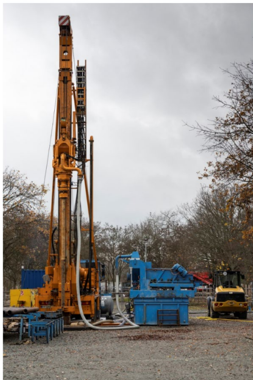
Foto: Bohranlage für Geothermie Rebstockbad Frankfurt. Quelle: Energiereferat / Foto: Hannes P. Albert
