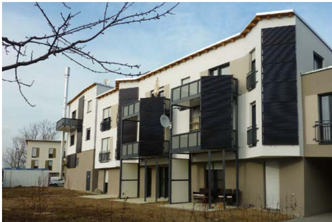
Außenansicht West des energieautarken Hauses. Quelle: BSMF
