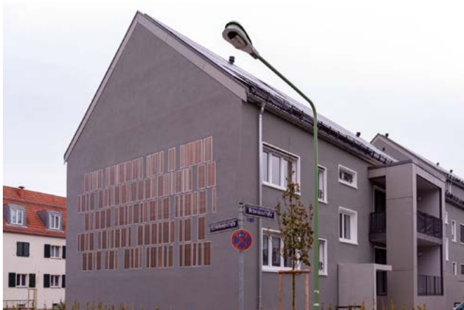
Organische Photovoltaik an der Fassade. Quelle: ABG FRANKFURT HOLDING / Foto: Ralf Pelkmann
