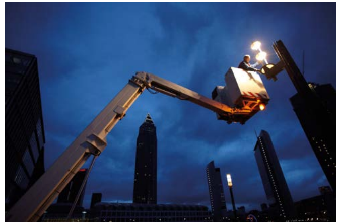
Arbeiten an der Straßenbeleuchtung. Quelle: Mainova AG
