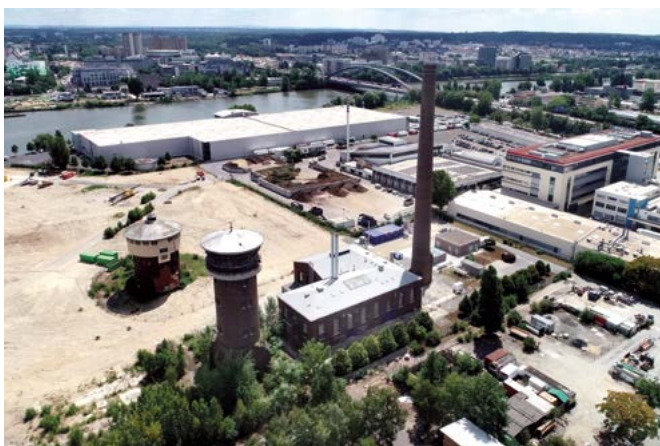
Klimaneutrales Biogas aus Bioabfällen. Quelle: Mainova AG
