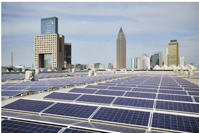
Energieernte für den Eigenbedarf – die neue Solaranlage auf dem Dach der Halle 12. Quelle: Messe Frankfurt Foto: Jean-Luc Valentin
