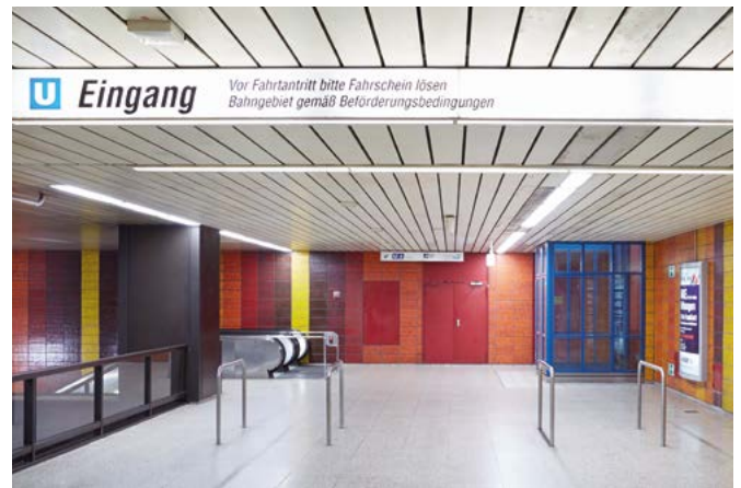
U-Bahnstation Höhenstraße mit neuer LED-Beleuchtung. Quelle: VGF
